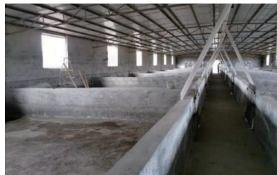
图 2-14 钢栏杆猪栏改为实体隔墙
